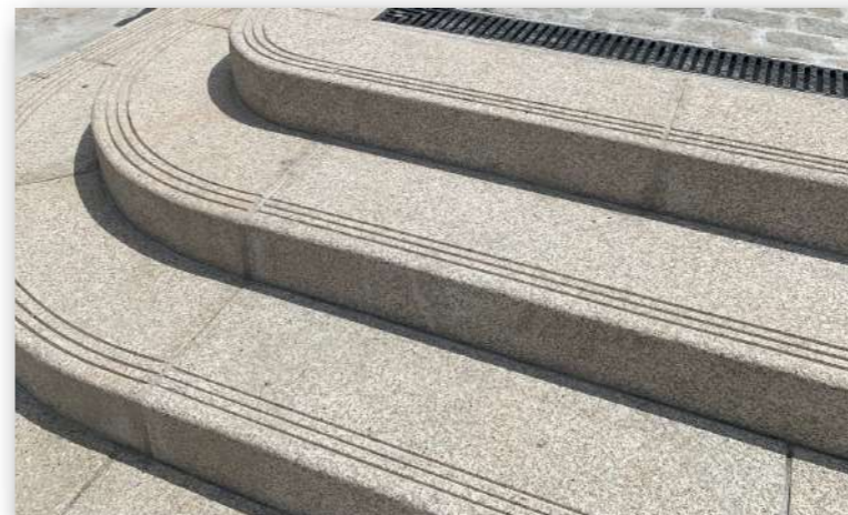
Marches en granit (neuve) ht.16 cm, largeur 40 cm, longueur libre courbe ou droite selon emplacement nez de marche rainurées conformément à la photo ci-contre
