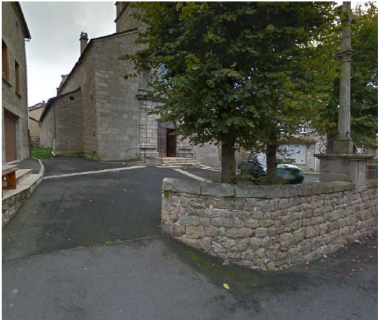
Mur 06 , état existant
