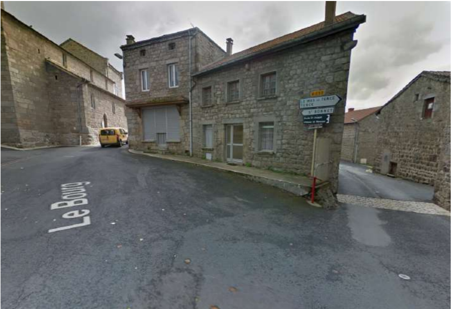
Mur 05 , Emplacement futur de l'aménagement
