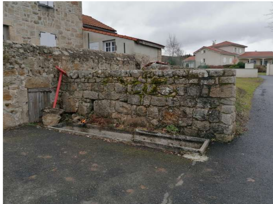
Mur 04 , état existant
